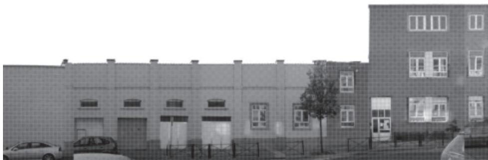
FIG. 2. LA MOSQUÉE AL KHALIL, FAÇADE RUE DELAUNOY : LA FAÇADE NE PERMET ABSOLUMENT PAS DE LIRE LA PRÉSENCE DU LIEU DE CULTE; SEUL LE TRAITEMENT UNITAIRE EN TERMES DE COULEUR DÉNOTE L'UNITÉ DU PROGRAMME QUE DES FAÇADES HÉTÉROGÈNES RENFERMENT. SOURCE : PHOTOMONTAGE, DOCUMENT TDA, 2012.
