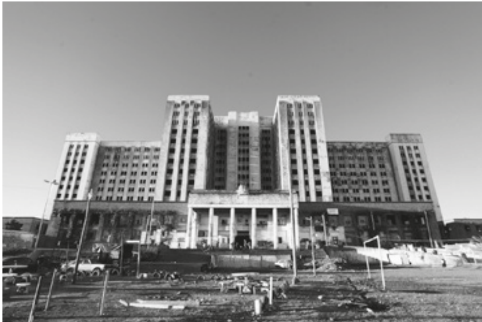
FIG. 2. FAÇADE AVANT DE EL ELEFANTE BLANCO SUR L'AVENUE PIEDRA BUENA. © PHOTO : TIPHAINÉ ABENIA, 2013.
