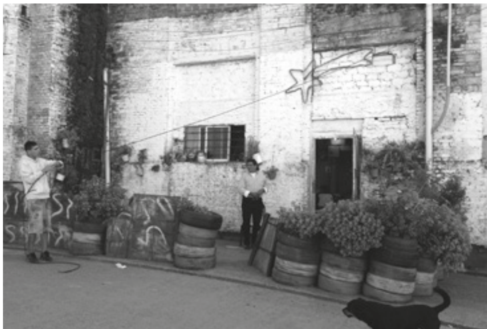
FIG. 6. INSTALLATION DE L'ÉCLAIRAGE SOUS LA COLONNADE D'ENTRÉE DE EL ELEFANTE BLANCO. © PHOTO : TIPHAINÉ ABENIA, 2013.
