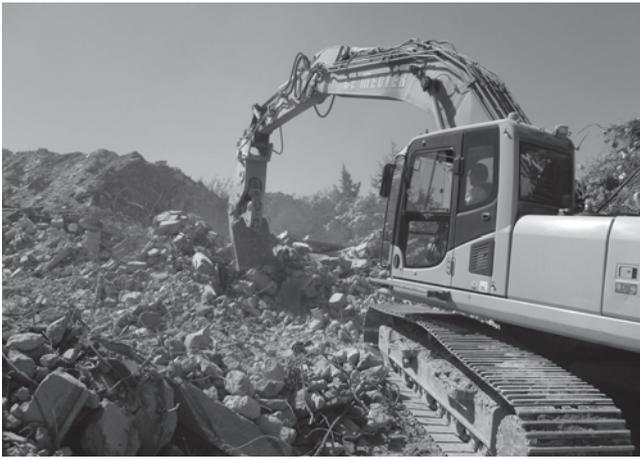
FIG. 1. EXTRACTION DES FERRAILLAGES À BÉTON DANS UN CENTRE DE CONCASSAGE DE DÉCHETS INERTES. SOURCE : ROTOR ASBL.
