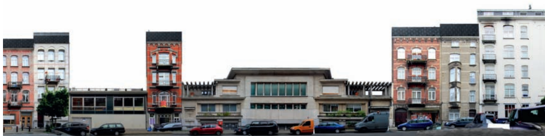
VUE EN ÉLEVATION ET MONTAGE PHOTOGRAPHIQUE DES FAÇADES RUE BERTHELOT ; ON REMARQUERA AU CENTRE DE L'ENSEMBLE L'ÉLÉMENT INCONGRU CONSTITUÉ PAR LA MAISON DES FEMMES.
