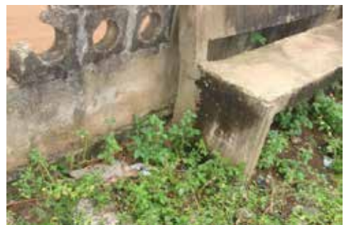
Vue d'un pan de la clôture, côté Est
