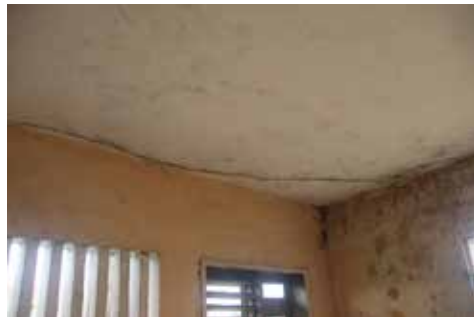
Intérieur du bâtiment de la radio
