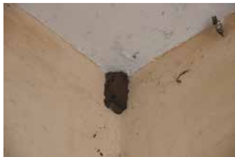
Intérieur du bâtiment de la radio
