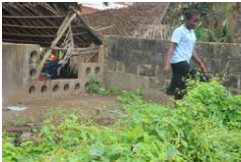
Ouverture due à la détérioration du mur de la clôture, côté est, servant d'accès à la place
