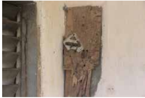
Pose compteur avec les fils électriques
