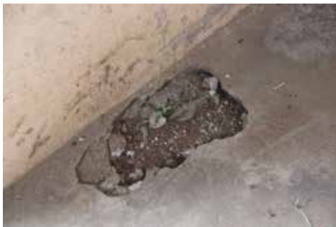
Etat de l'intérieur du bâtiment
