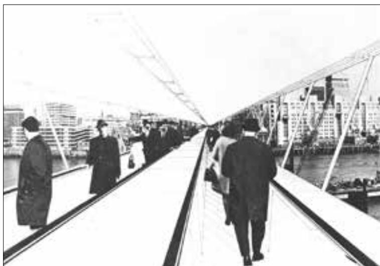
FIG. 9. SPEEDAWAY LINKS TRAVERSANT LA TAMISE: «VUE INTÉRIEURE LE LONG DU SYSTÈME QUI PEUT TRANSPORTER JUSQU'À 10 000 PERSONNES PAR HEURE DANS CHAQUE DIRECTION...» (RICHARDS, 1976)
