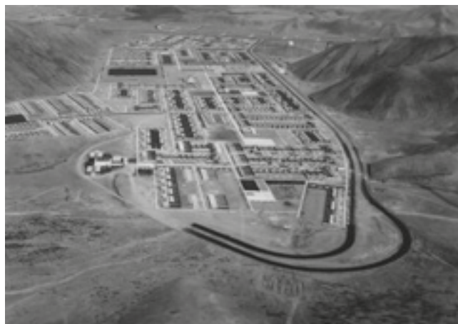
FIG. 8.1. AERIAL VIEW OF VENTANILLA, 1963. © SOURCE: ARCHIVO DEL SERVICIO AEROFOTOGRAFICO NACIONAL.
